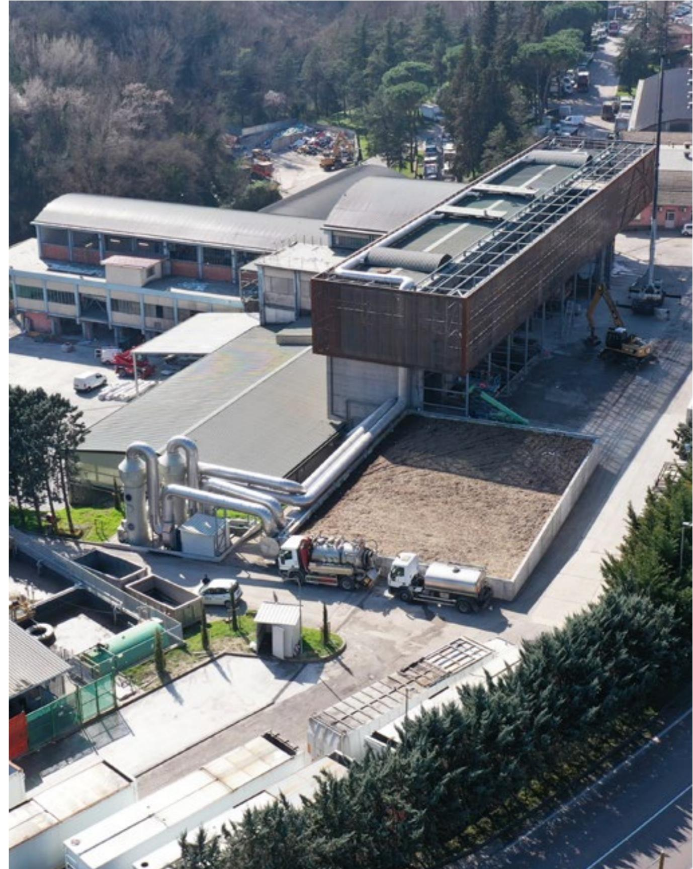
Il **Polo di Pietramelina** è attualmente costituito da una discarica che si trova nella fase di "pre-chiusura", da un impianto di trattamento del percolato da discarica con una capacità di trattamento pari a circa 150 m<sup>3</sup>/giorno e un impianto di biostabilizzazione che effettua il trattamento della Frazione Organica derivante dalla selezione dei Rifiuti Solidi Urbani (FORSU) con una potenzialità massima di trattamento di 35.000 ton/anno.
